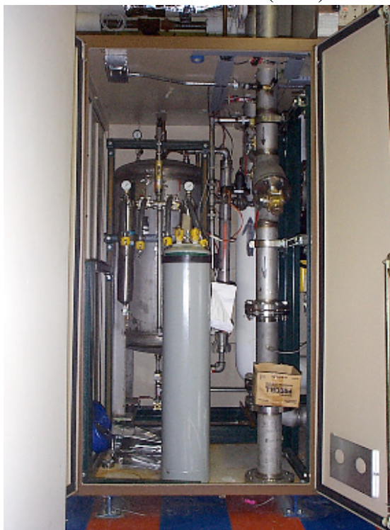
Fig. 6.30 Klystron Tanks
